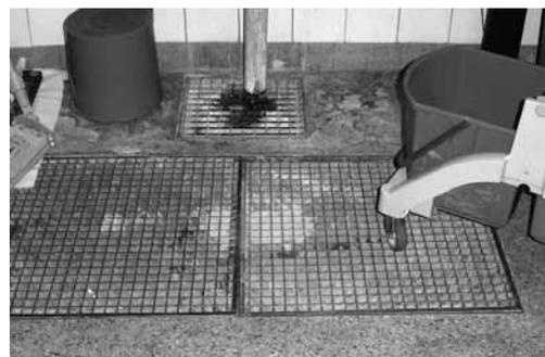
Figure 1: les grilles antidérapantes et au même niveau que le sol évitent les accidents par glissade.
