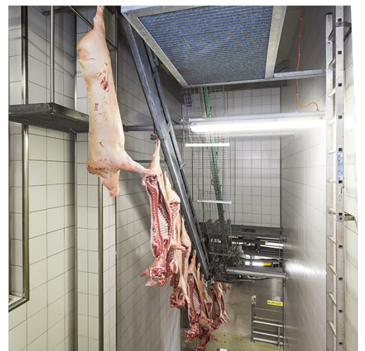
Bild 7: Von Verkehrswegen getrennte Rohrbahn
