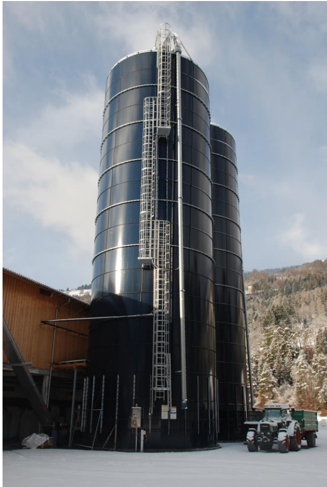
Plateformes intermédiaires et échelles décalées
