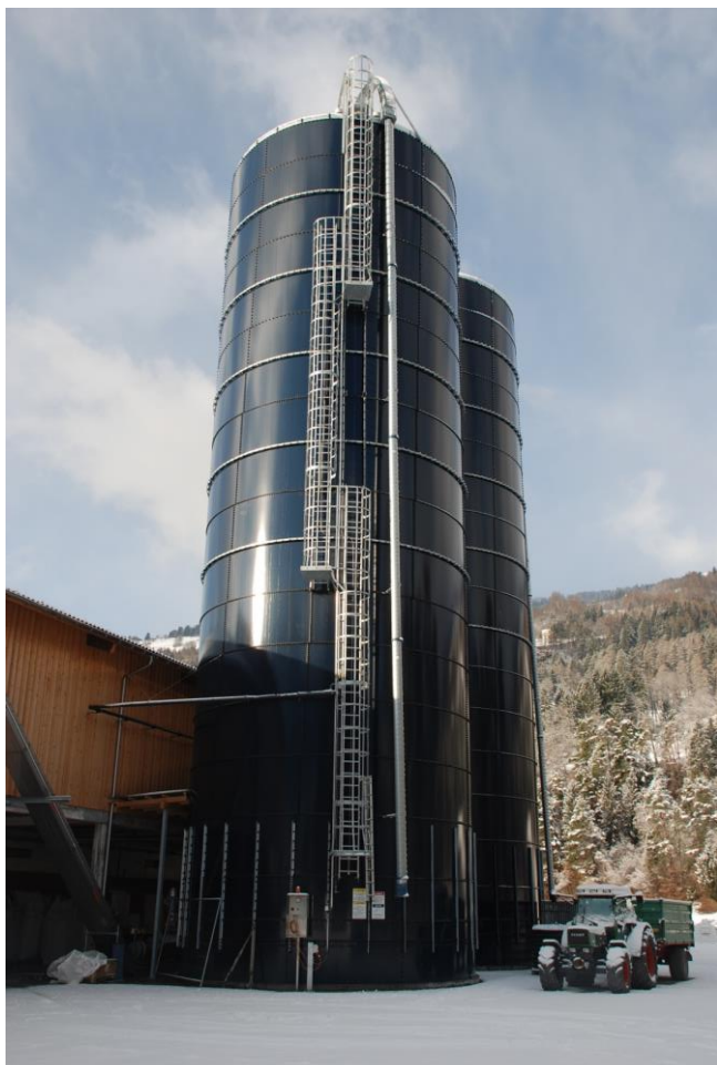
Pianerottoli intermedi sul silo a torre.
