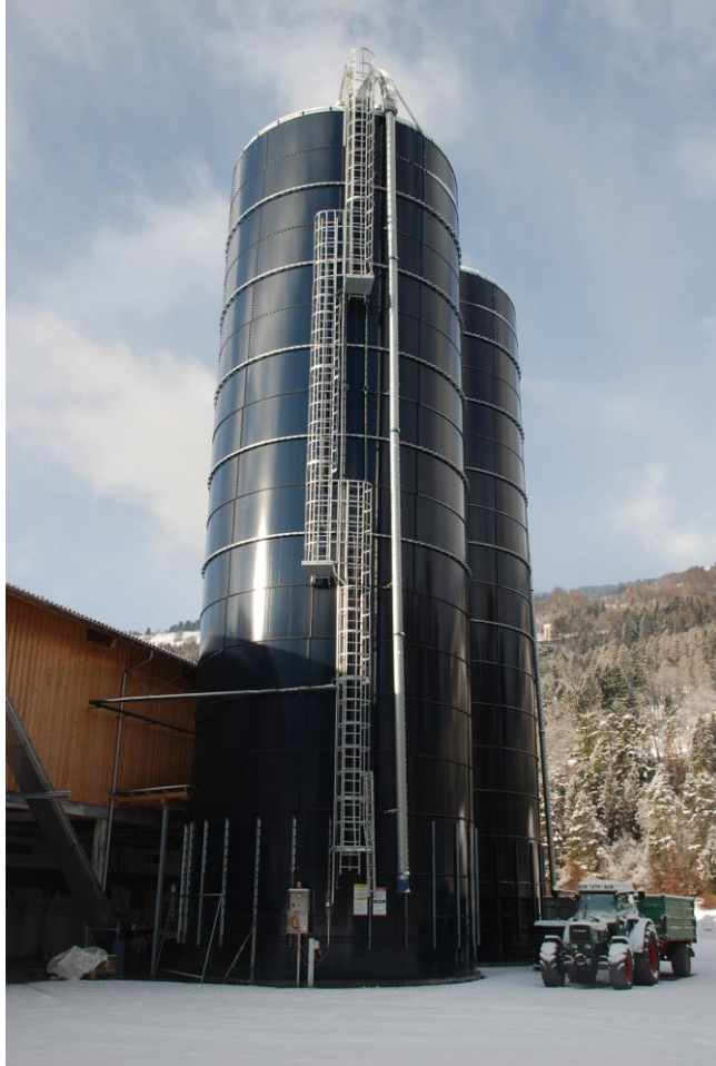
Versetzte Zwischenpodeste am Hochsilo
