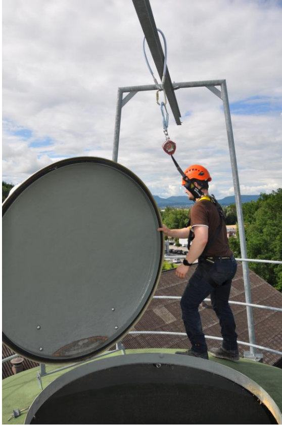
Persönliche Schutzausrüstung gegen Absturz sichert die Person gegen den Absturz in das Hochsilo
